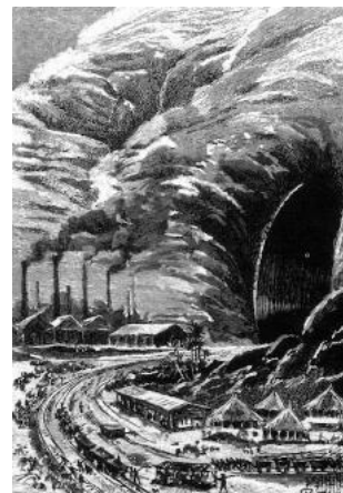
Le colossal chantier du Gun-Club
