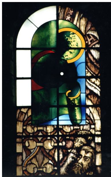
Œilleton de la méridienne de la cathédrale de Nevers (inséré dans un vitrail) tel qu'il peut être observé aujourd'hui
