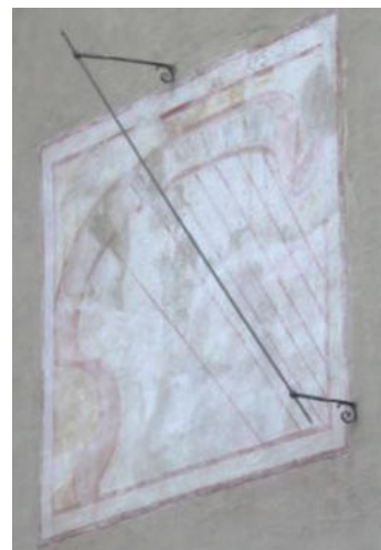
Fig. 9 : restauration d'un cadran solaire de 1546 à Allentsteig, Basse Autriche (remplacement du gnomon disparu)
