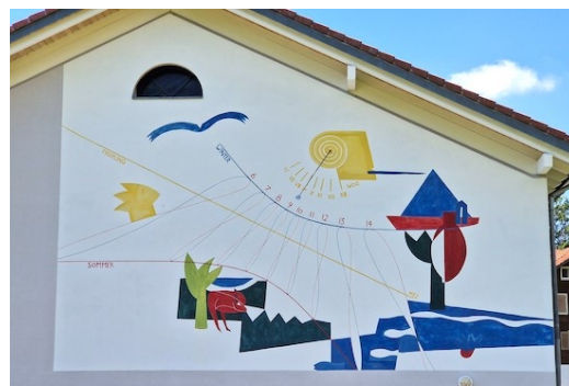
Photo 9 : Cadran solaire du bâtiment polyvalent de Flüeli-Ranft
