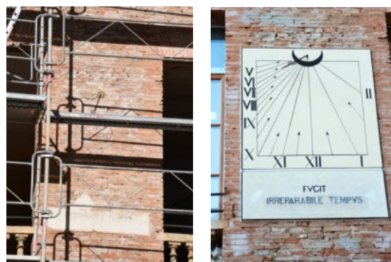
Après le passage des maçons seule reste la devise, qui sera déposée et intégrée dans la nouvelle table
