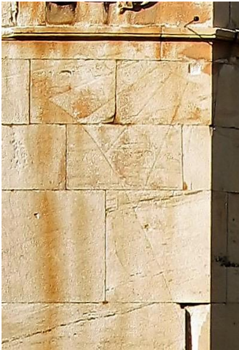
Face sud-est : les tracés originaux sont encore visibles en lumière rasante ; la place du style est très approximative ...
